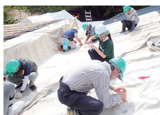
屋根に登ってテント補修
