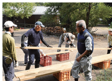
協力して橋の修繕準備
