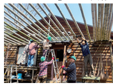
テントの骨組み作業
