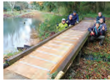
見事なまでの修繕技術!
