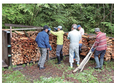
薪棚の屋根作り
